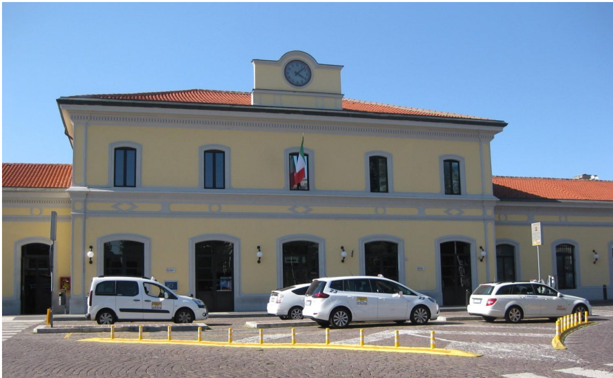
Figura 12 - Stazione ferroviaria Pavia, vista da Piazza Stazione, incrocio Via Giovanni Falcone e Paolo Borsellino
